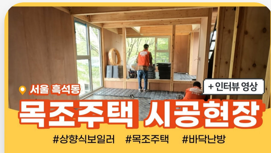
[호야온돌] 목조주택 시공현장
