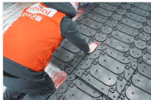
호야온돌 하판 설치 (단열차음재)
