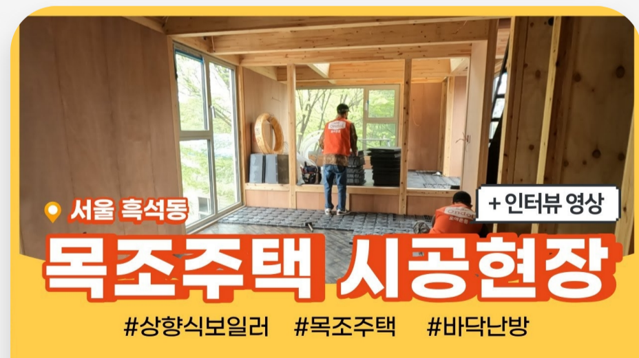
[호야온돌] 목조주택 시공현장
